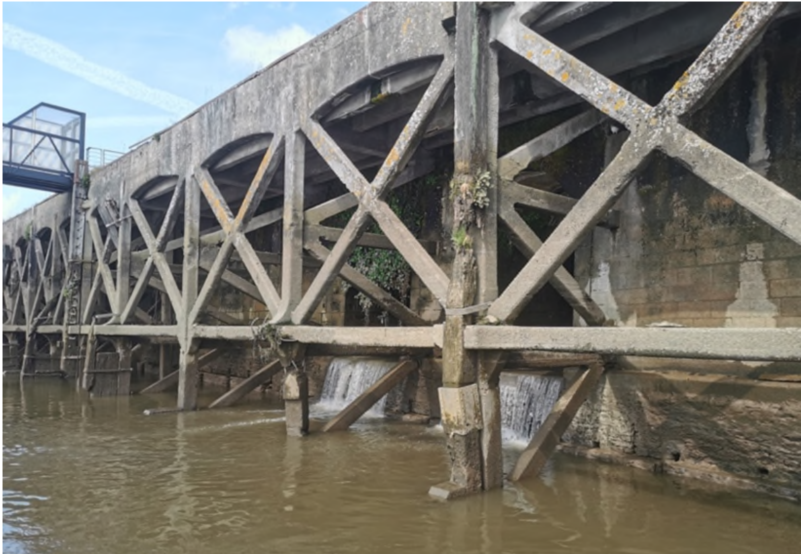
Figure 3 : Vue du Quai de la Fosse au niveau de l'ouvrage hydraulique de la Chézine – 29 avril 2025 (Source : JF SEROT)
