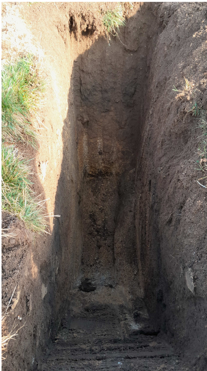
Fond de fouille
