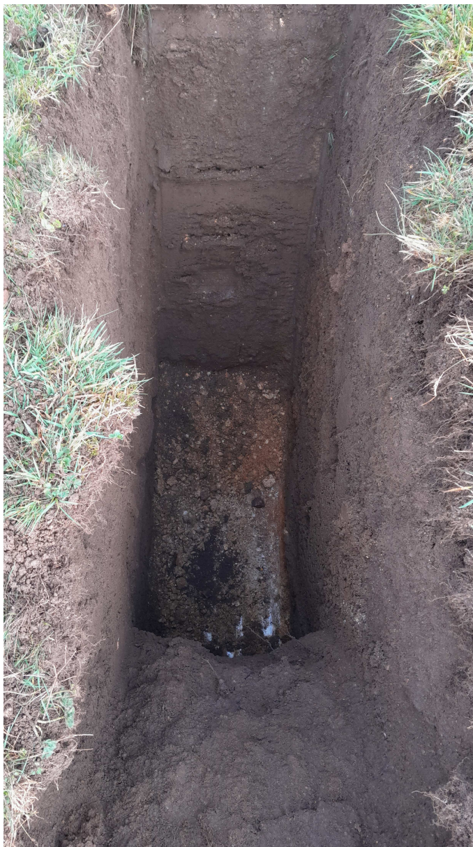
Fond de fouille
