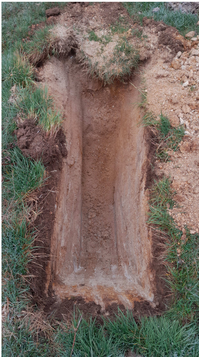
Fond de fouille
