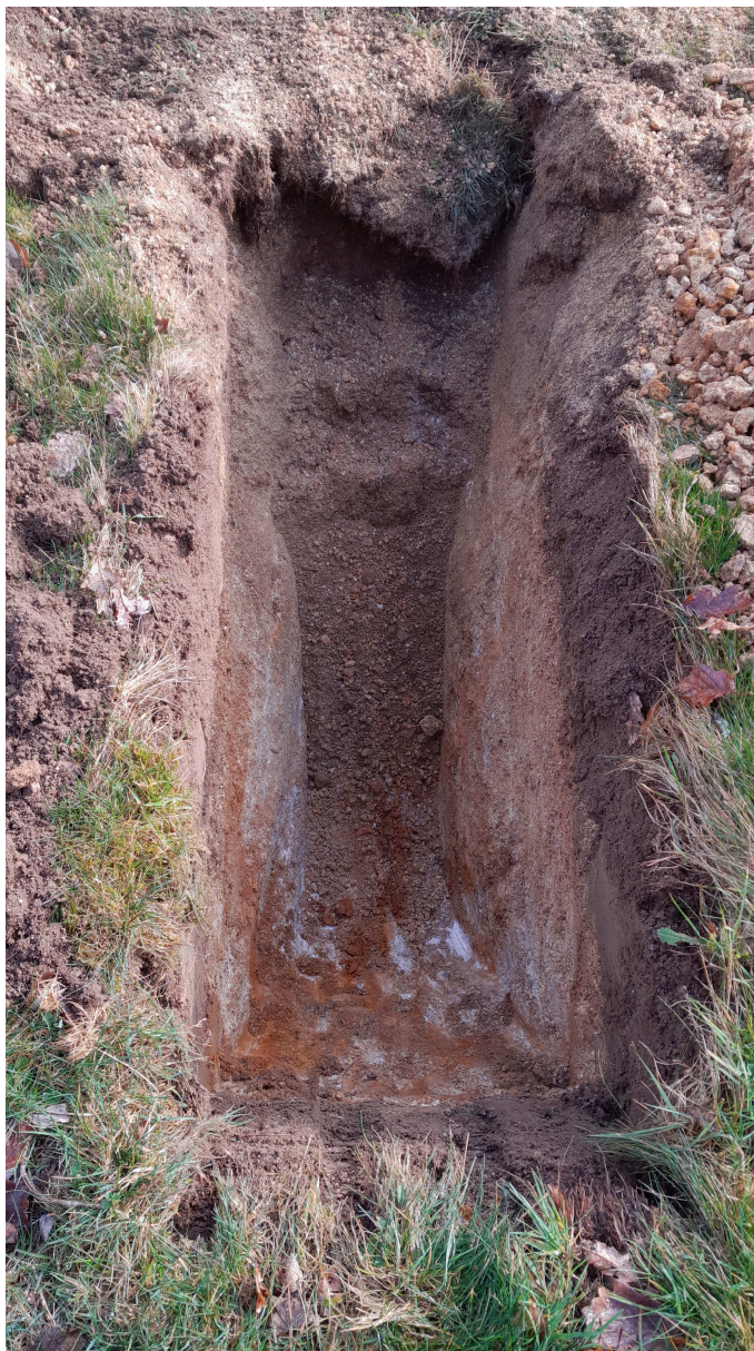
Fond de fouille
