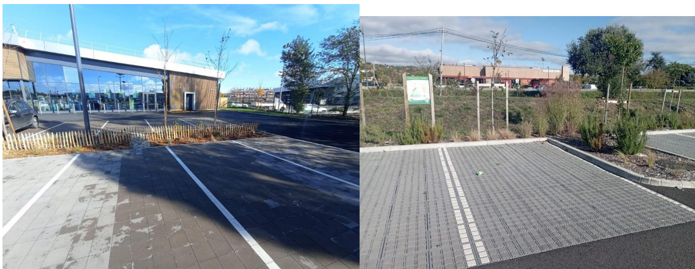
Figure 15 : Exemples de pavés drainants et noue de gestion à la source mis en place au sein de stationnements de Lidl existants (source : ADRET Nature, 2025)
