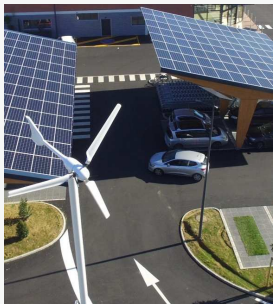
OMBRIERES PHOTOVOLTAÏ QUES Produire et utiliser l'énergie locale
