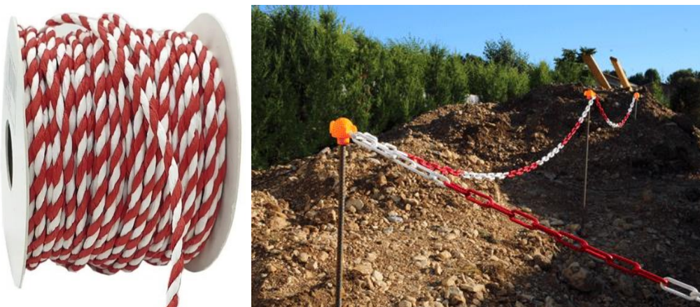
Figure 5 : Illustration du balisage avec corde peinte et chainette
