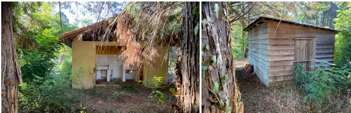
Bâtiments existants à rénover
