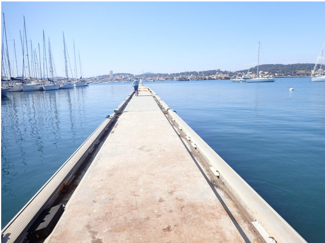
Photo n°2 : Photographie du brise houle du Port de Pin Rolland (ICTP 2021)
