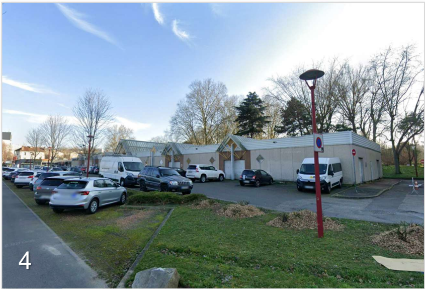
Vue sur les locaux du marché de FRESNES et leurs abords côté nord depuis l'ouest
