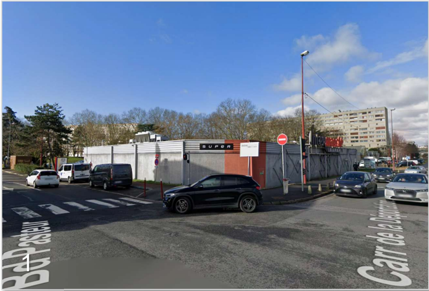
Vue sur les locaux de l'Intermarché depuis le croisement du boulevard Pasteur et du Carrefour de la Déportation
