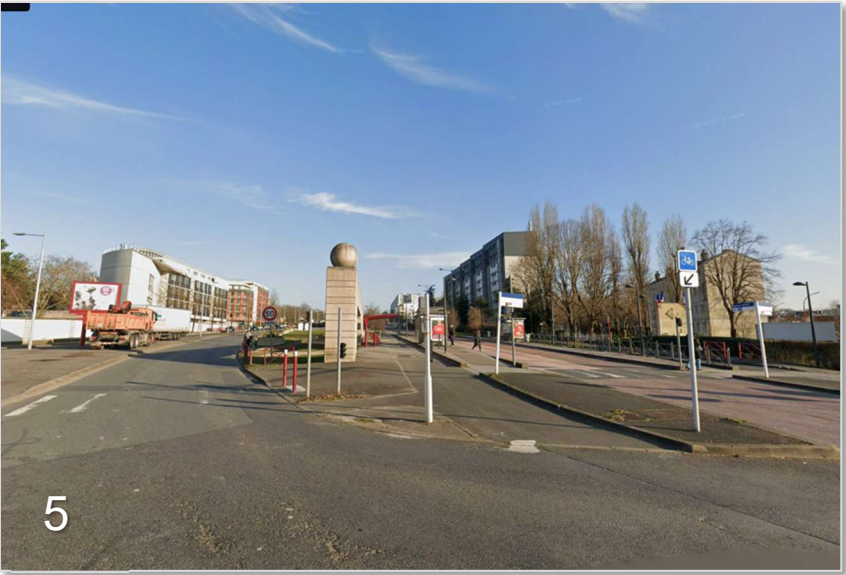
Vue sur les différentes voiries sur la partie couverte de l'A86 depuis le Carrefour de la Déportation
