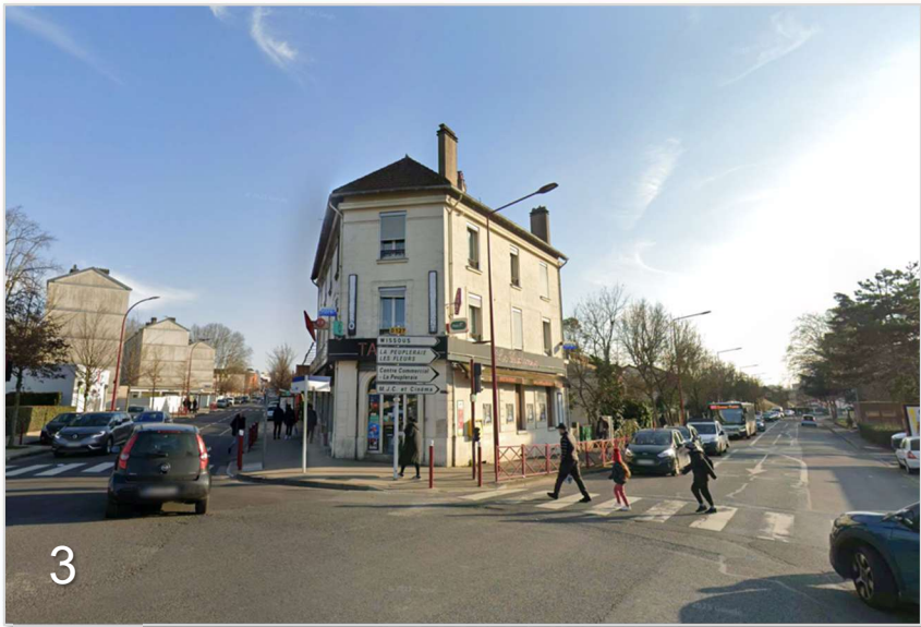
Vue sur le bâti existant au croisement du boulevard Pasteur et de l'avenue de la République
