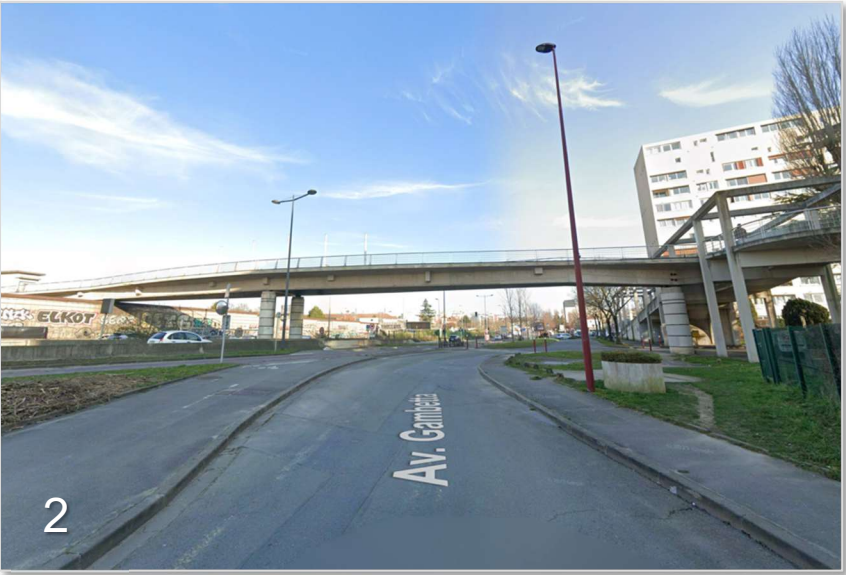
Vue sur la Passerelle de la Bièvre depuis l'avenue Gambetta
