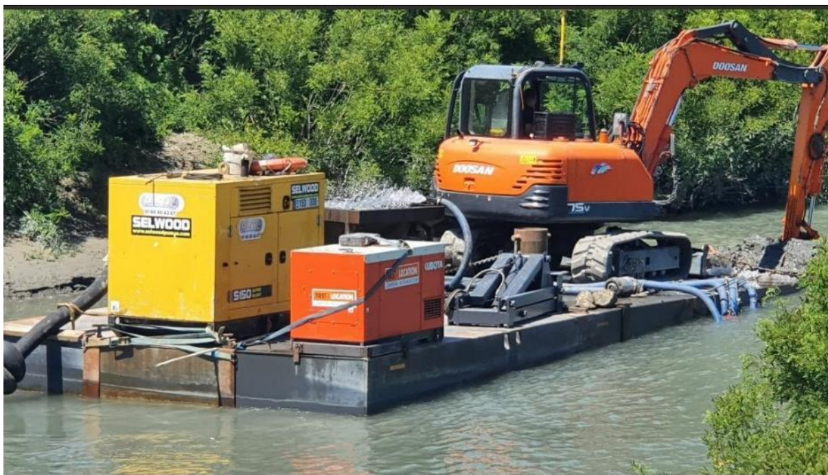
Figure 14. Pelle embarquée sur barge, trémie de malaxage et conduite de refoulement du type de celle employée pour les travaux
