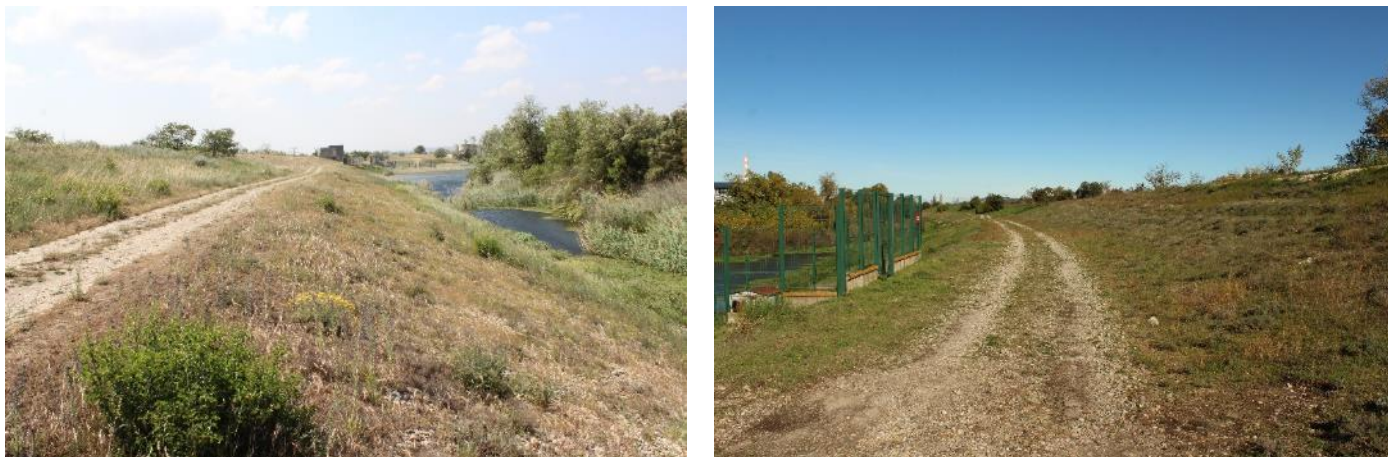
Figure 8. Parement aval de la digue au droit du bassin Célestin (ACME – 2023/2025)
