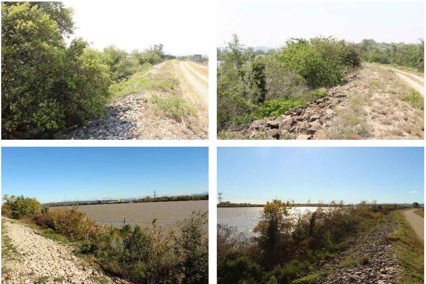
Figure 9. Parement amont de la digue (ACME – 2023/2025)
