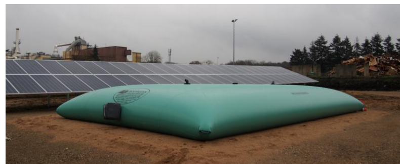
Figure 8 : réserve incendie souple 60 m 3 (source : SOG SOLAR)
