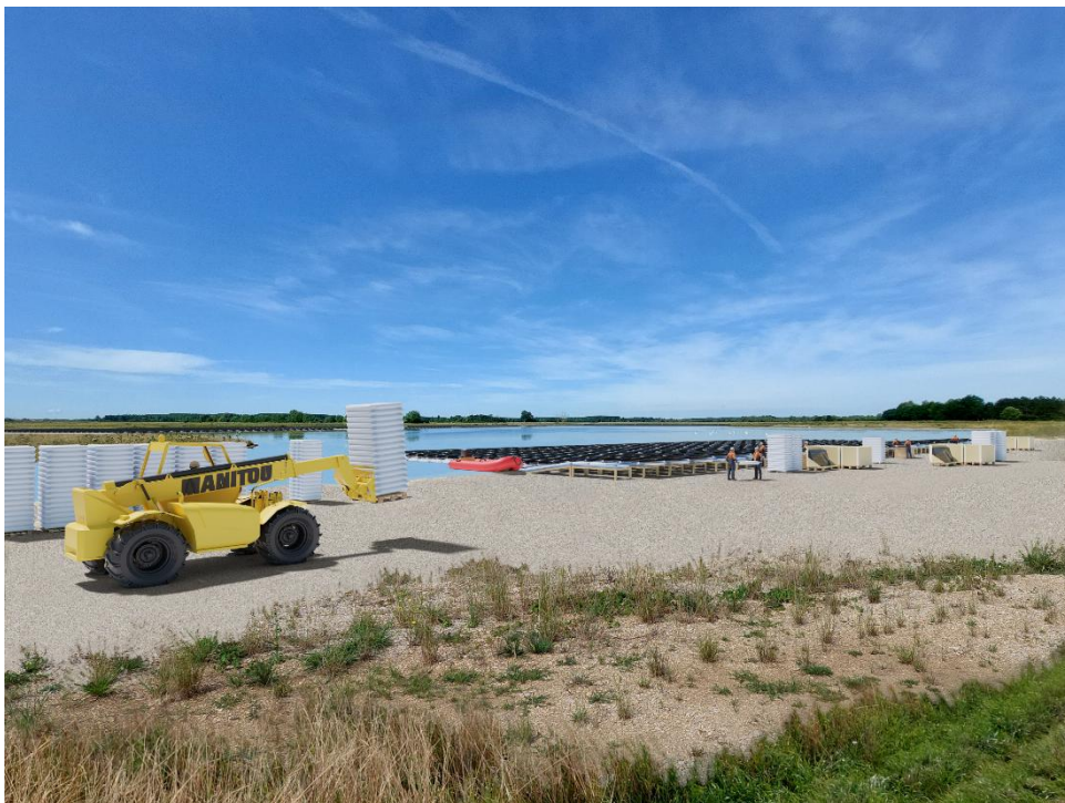
Figure 12 : photomontage présentant le montage des structures et leur mise à l'eau sur un projet flottant (source : UNITE)
