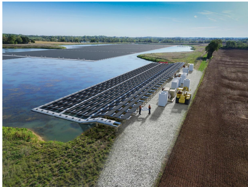
Figure 13 : photomontage présentant le montage des structures et leur mise à l'eau sur le site de la centrale de Norrois (source : UNITE)
