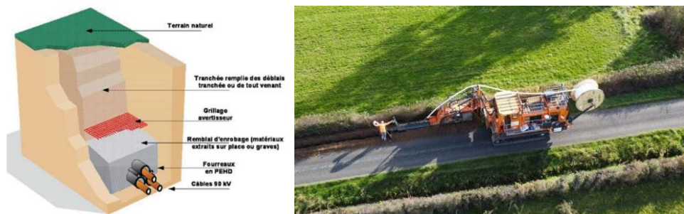
Figure 11 : pose des lignes souterraines (source : CEGELEC)
