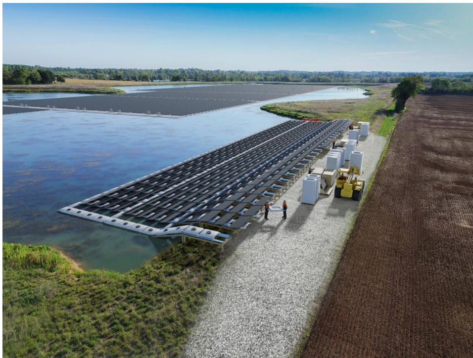
Figure 18 : photomontage présentant le montage des structures et leur mise à l'eau sur le site de la centrale de Norrois (source : UNITE)
