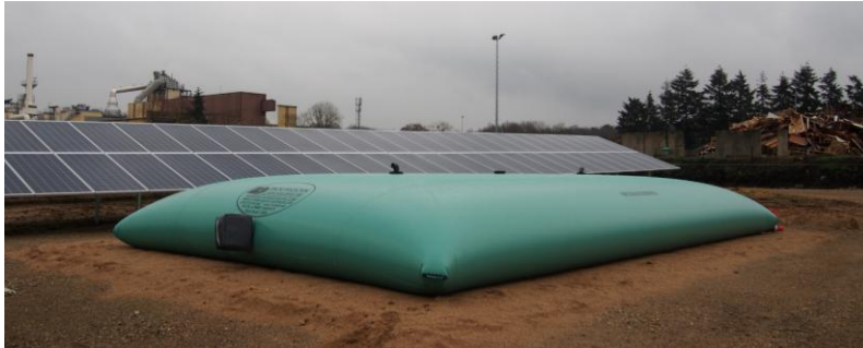
Figure 2 : réserve incendie souple 60 m3 (source : SOG SOLAR)
