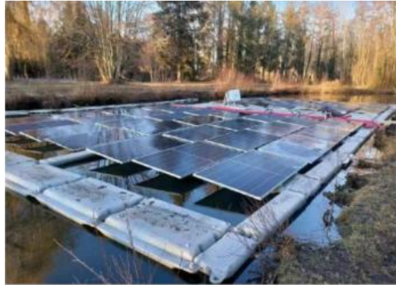
Figure 10 : ilot flottant avec des panneaux posés avec 5° d'inclinaison vers le sud, comme a choisi d'installer UNITE (source : @Ciel et Terre)
