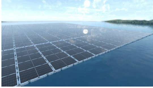
Figure 9 : ilot flottant de panneaux posés à plat sur les flotteurs, peu recommandé (source : Phelan Energy Group)
