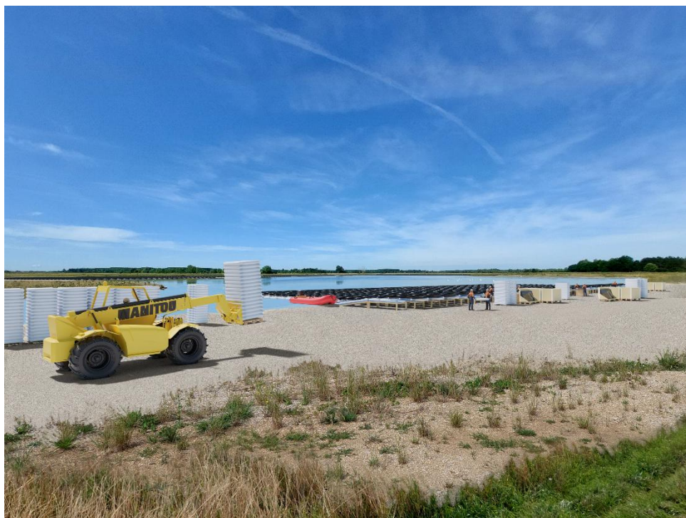
Figure 17 : photomontage présentant le montage des structures et leur mise à l'eau sur un projet flottant (source : UNITe)
