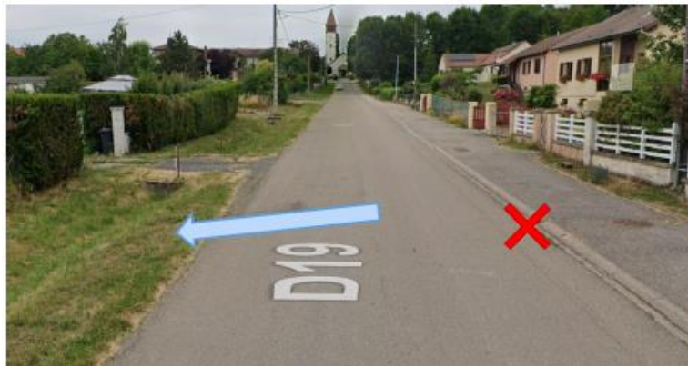
Figure 14 : Aménagement de la voirie rue de l'Étang (Emberménil) pour gérer les eaux pluviales dans le fossé existant
