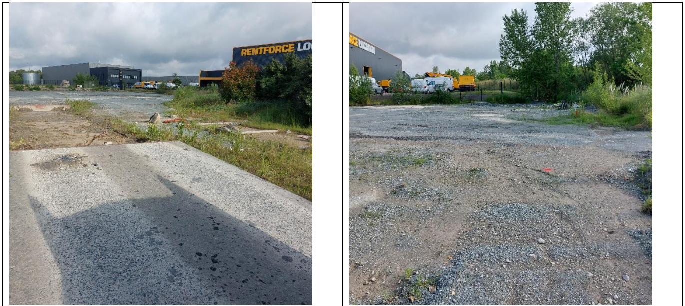
Figure 6 : Photographies du site (21/05/2025)
