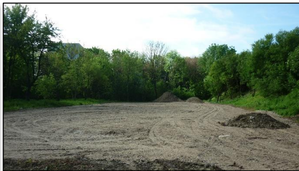
Figure 27 : Parcelle projetée de la STEU, partie aménagée – (Source : ARTELIA – 02/05/2024)
