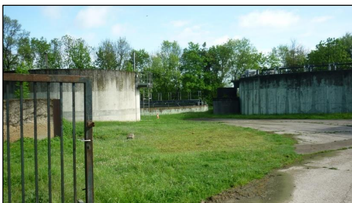
Figure 26 : Photographie de la station d'épuration d'Arcis – sur – Aube (Source : ARTELIA – 02/05/2024)
