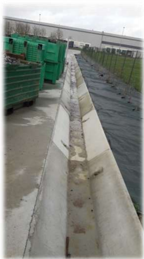
Photo 4 : Fossé périphérique sud-est
