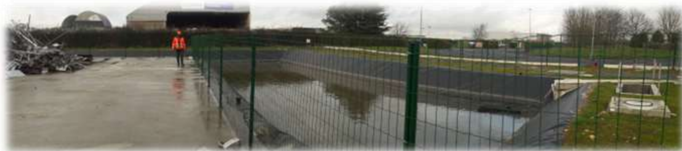
Photo 2 : Bassin de rétention
