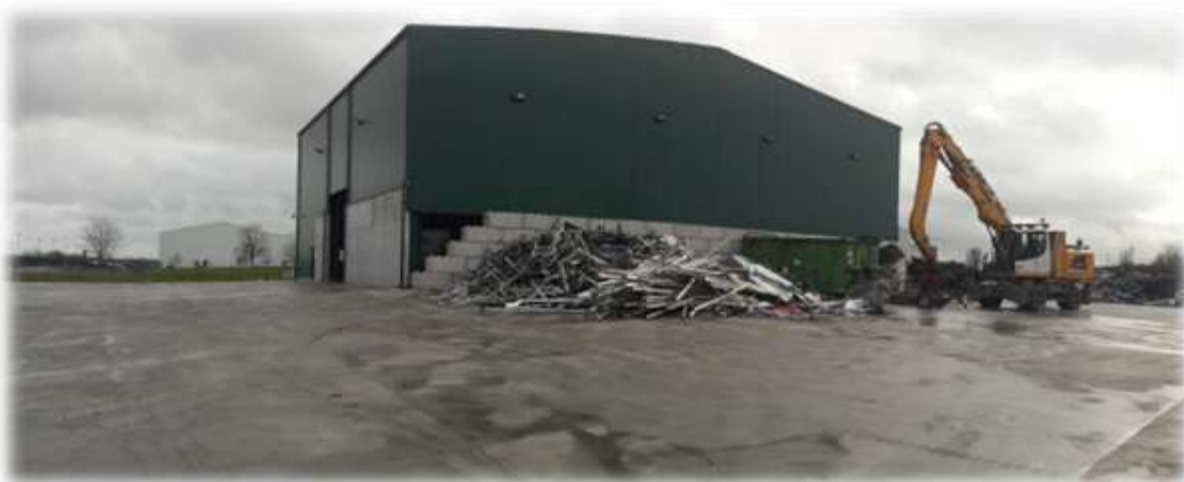
Photo 6 : façade nord-ouest du bâtiment
