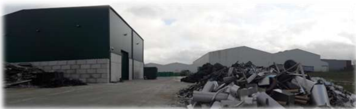
Photo 7 : façade sud-ouest du bâtiment et vue sur l'entrée du site
