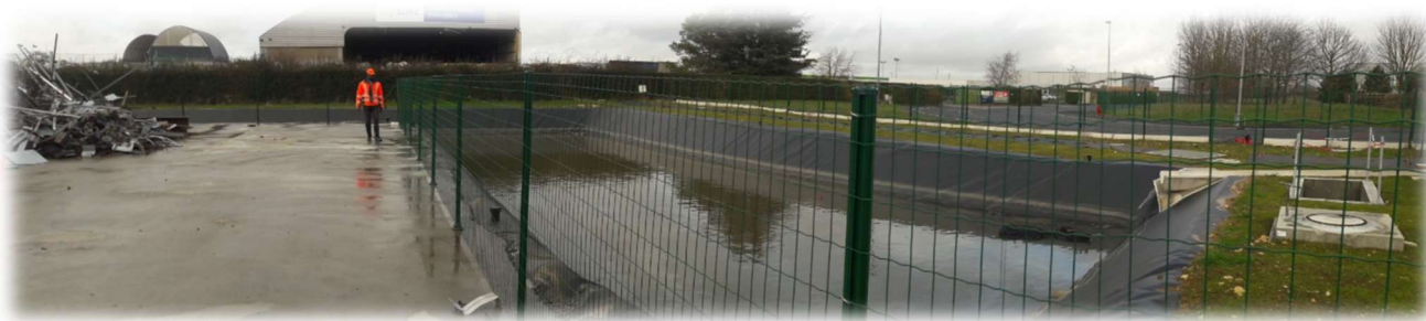
Photo 6 : Fossé périphérique nord-ouest
