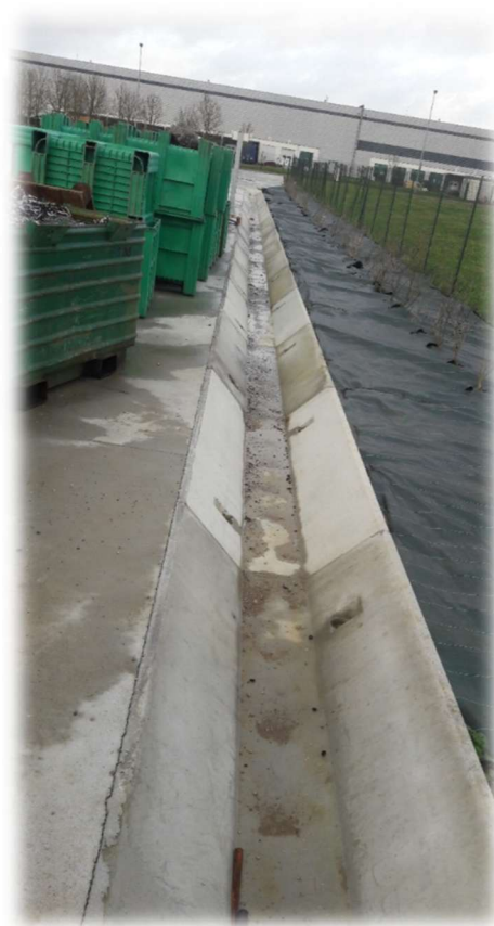
Photo 7 : Fossé périphérique sud-est
