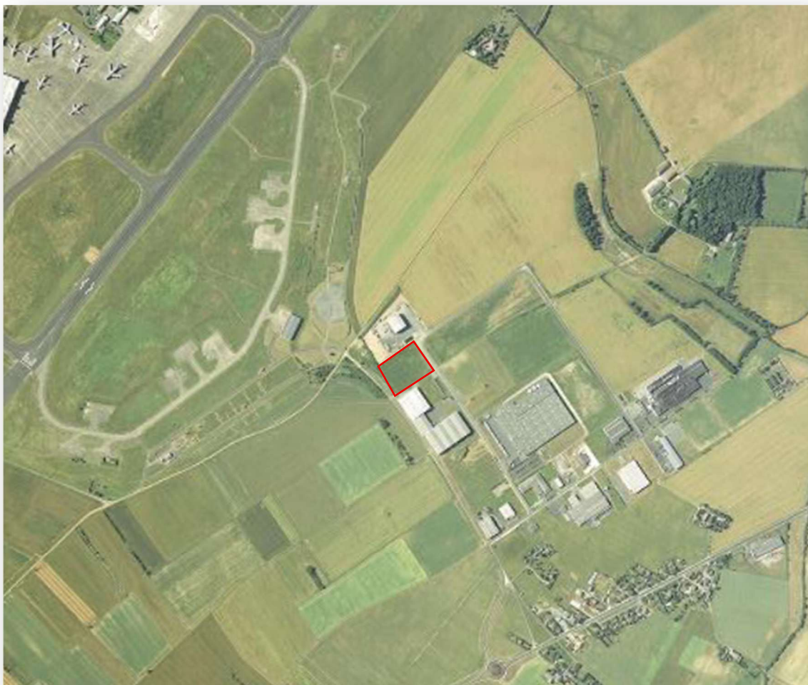
Photo 2 : photo aérienne du site 19 juin 1999
