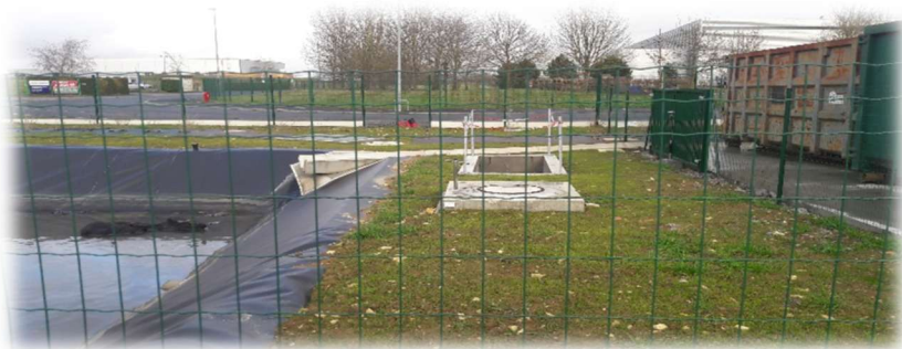
Photo 5 : Fossé périphérique nord-ouest
