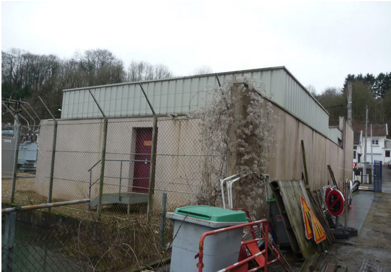
Les bâtiments du poste
