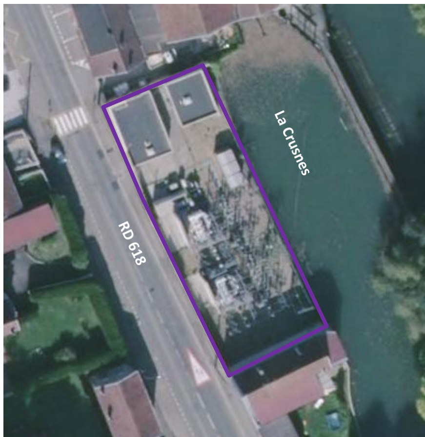
Vue aérienne du poste entre la RD 618 et la Crusnes
