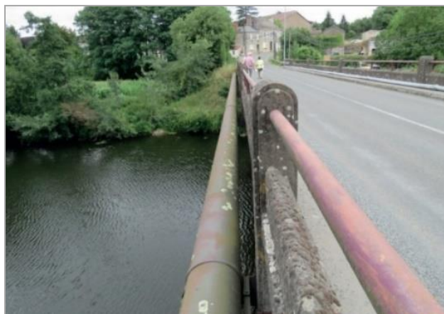
Figure 19 | Exemple de pose en encorbellement
