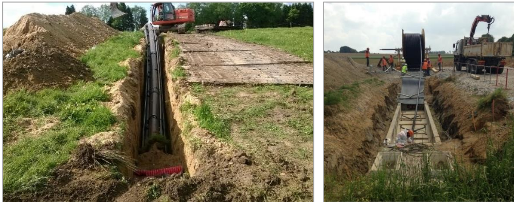
Figure 13 | Pose des fourreaux PEHD (à gauche) et déroulage d'une liaison souterraine au niveau d'une jonction (à droite)
