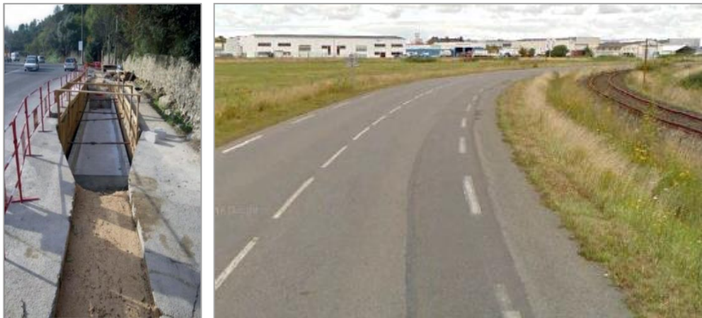
Figure 14 | Chambre de jonction (à gauche) et réfection d'une chaussée après travaux (à droite)
