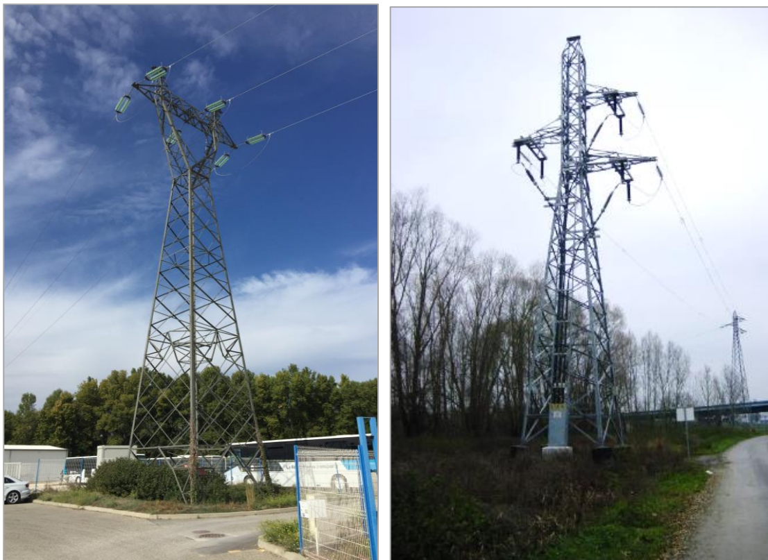
Figure 90 : Pylône treillis de type aérien (à gauche) et aéro-souterrain (à droite)
