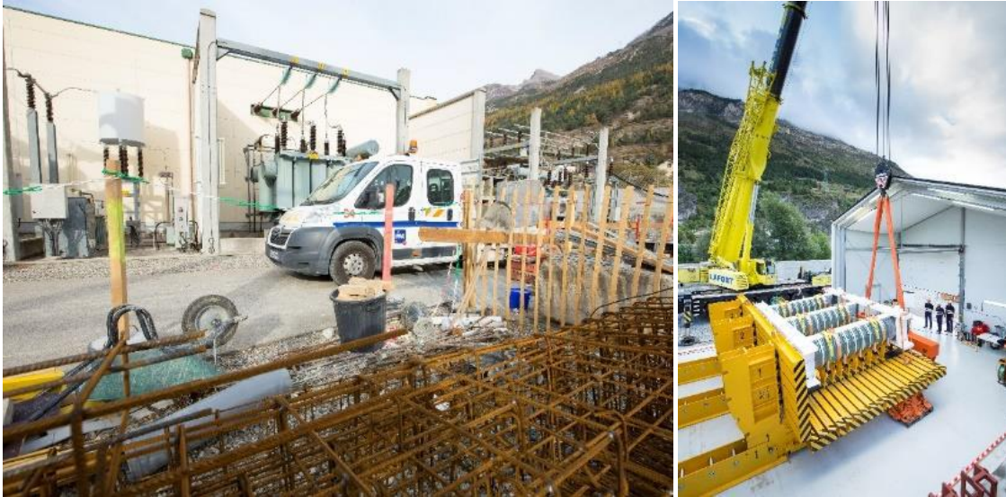
Figure 65 | Construction d'un poste de transformation
