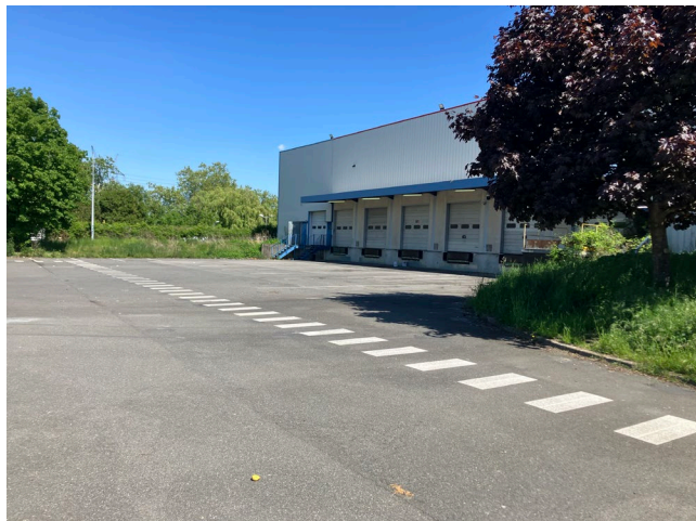
12. Vue du quai de chargement à l'Ouest du bâtiment
