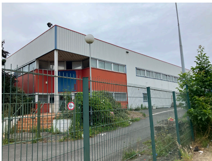
8. Vue de l'angle Sud-Ouest du bâtiment
