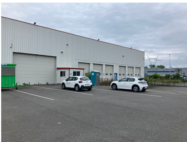
3. Vue du bâtiment depuis le parking est
