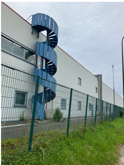
7. Vue de la façade Sud du bâtiment
