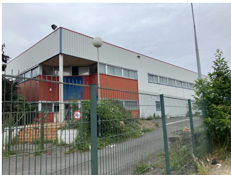
8. Vue de l'angle Sud-Ouest du bâtiment
