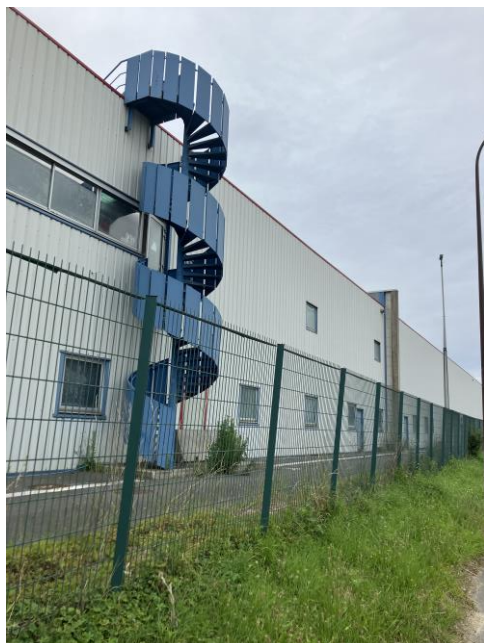
7. Vue de la façade Sud du bâtiment
