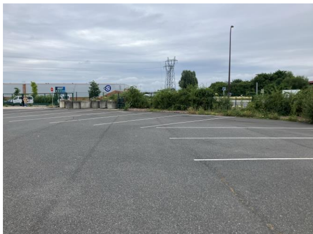
1. Vue du parking Est
