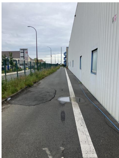
6. Vue de la voie longeant le Sud du bâtiment
