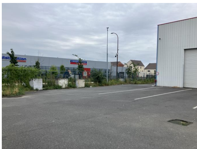
5. Vue depuis le parking Est du centre de distribution
