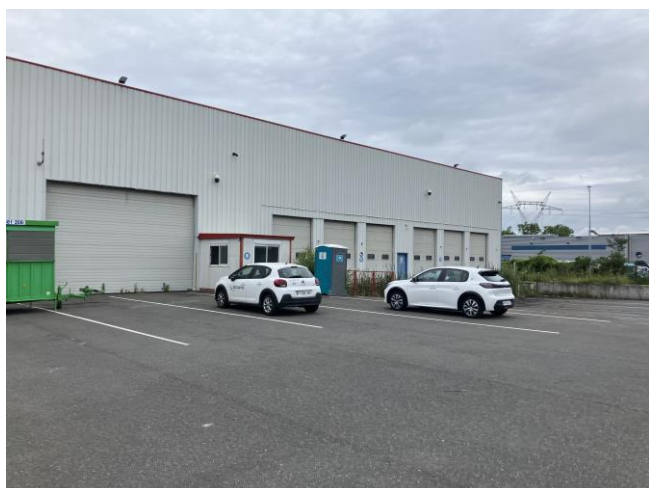
3. Vue du bâtiment depuis le parking Est
