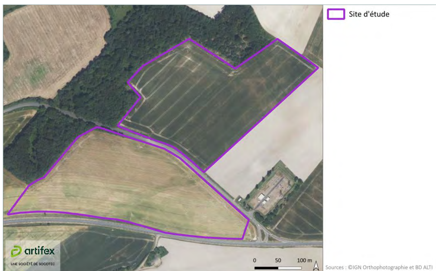
Illustration 3 : Vue aérienne du site d'étude Réalisation : Artifex 2025
