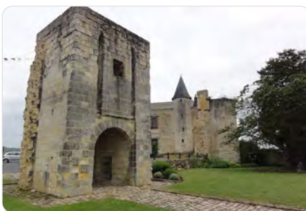
MH2 - Château des Rohan
