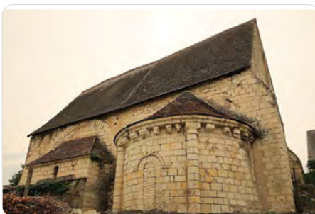
MH5 - Chapelle priorale Saint-Mesmin
