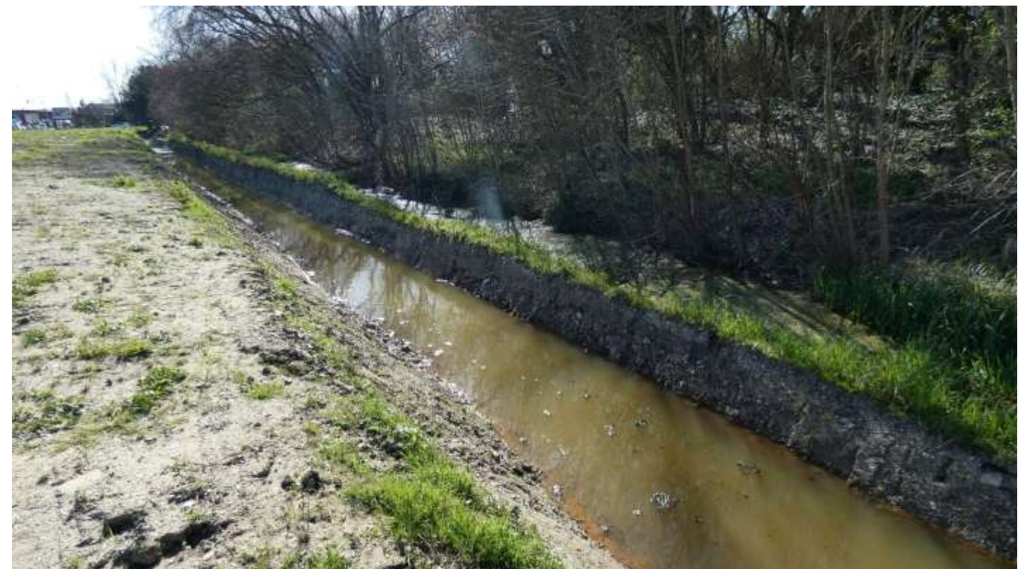
Figure 18: fossé en eau ; photo prise sur l'AEI
