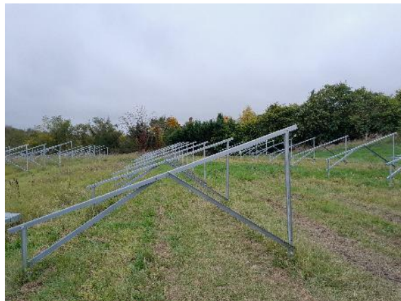
A gauche : structures avec pieux battus (projet Enercoop – St Amant Tallende (63) – 2024)
