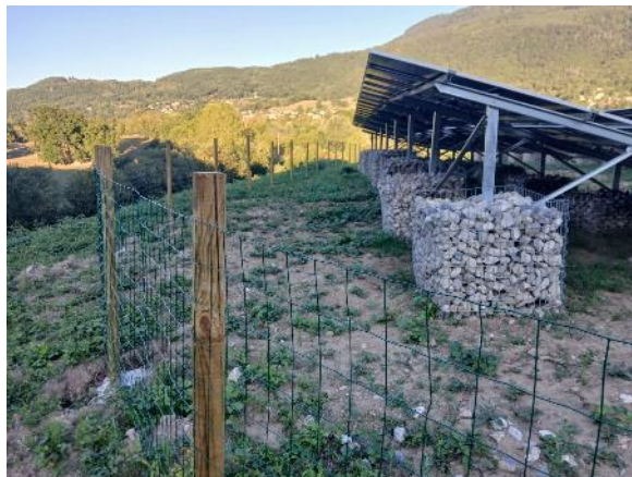
A gauche : structures avec pieux battus (projet Enercoop – St Amant Tallende (63) – 2024)
