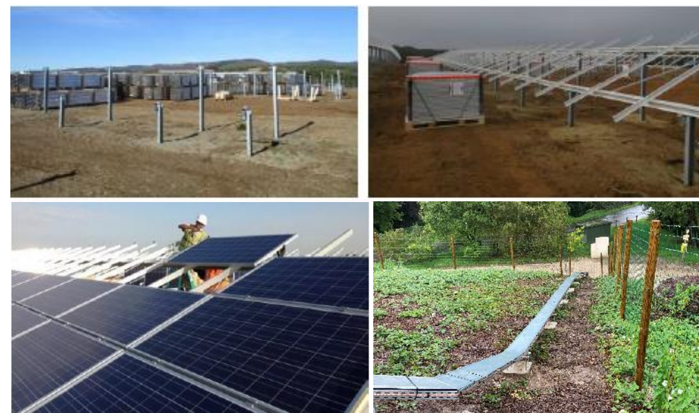
Photographies d'illustration de la phase de travaux
