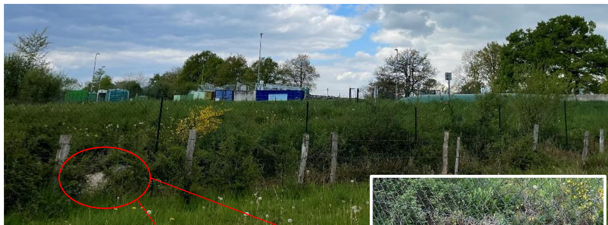
Vue de la déchèterie depuis le terrain à l'Est et de l'exutoire de des tranchées
