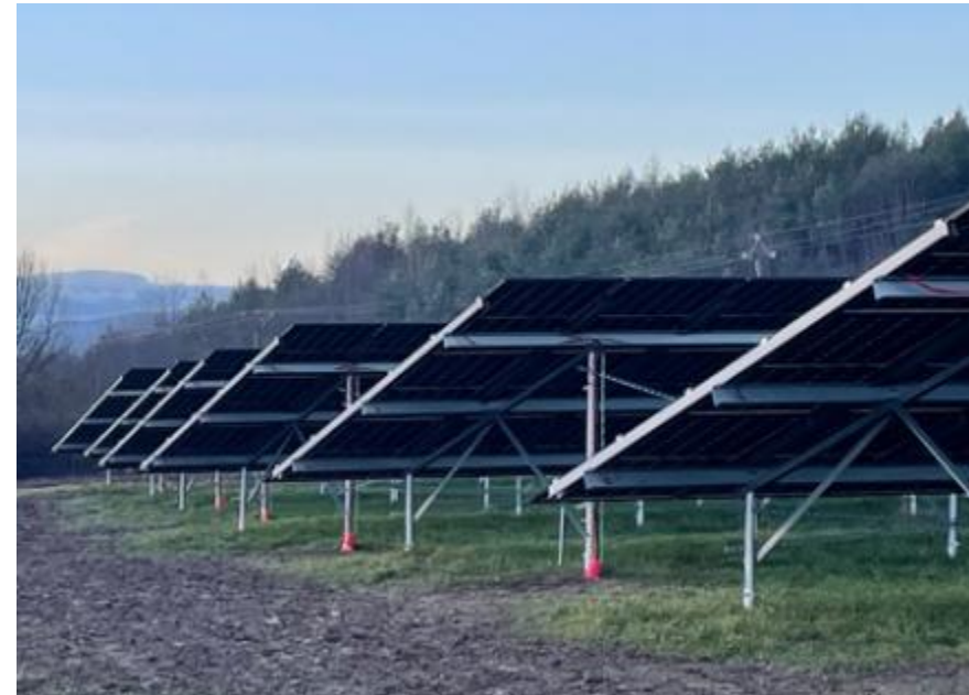
Exemple de structures fixes. Source : parc solaire d'Enercoop AURA à Beauregard-Vendon dans le Puy-de-Dôme (63) sur un délaissé d'autoroute
