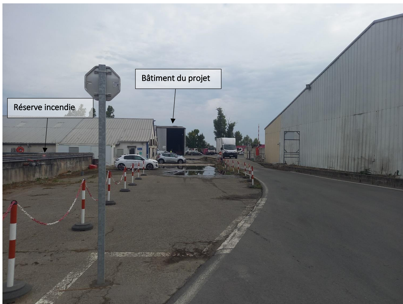
Figure 6 : Prise de vue 6 - Depuis l'installation voisine Sud et la réserve incendie de la zone
