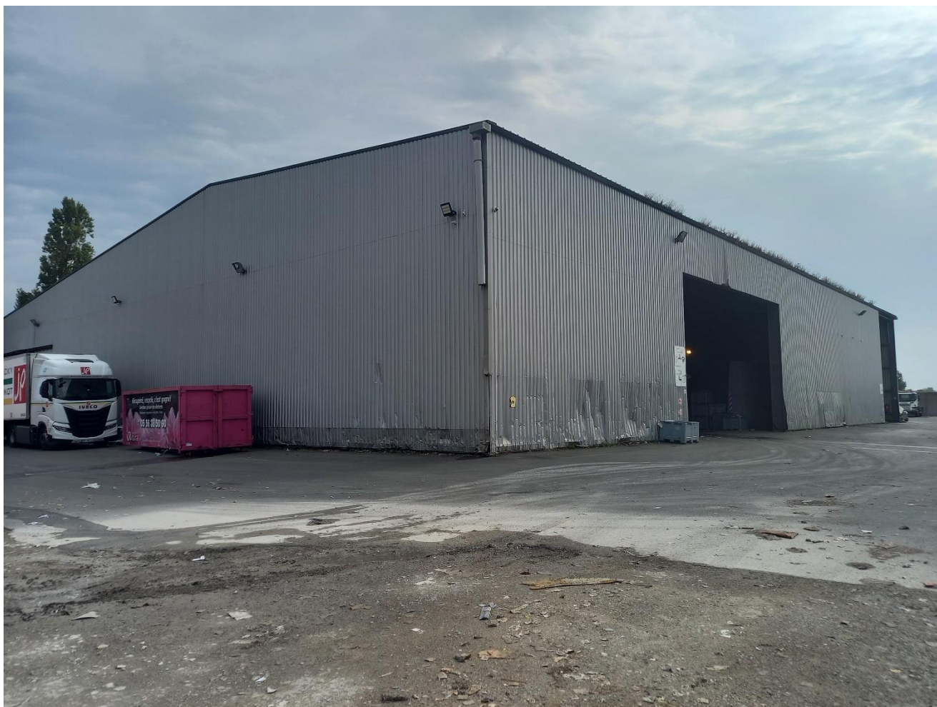
Figure 2 : Prise de vue 2 - Zone Nord Ouest du bâtiment
