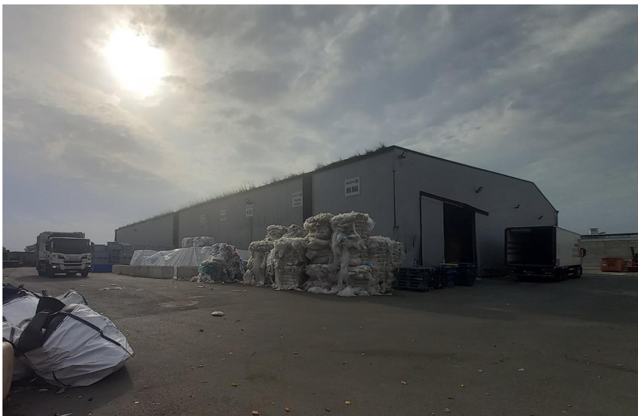
Figure 4 : Prise de vue 4 - Zone Sud-Ouest du bâtiment
