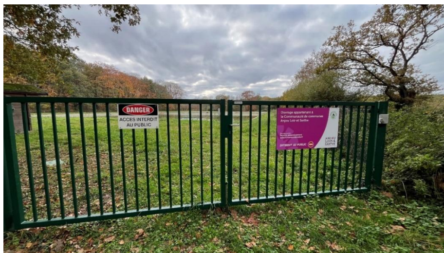
Figure 3 : Portail d'entrée de la station d'épuration de Montreuil sur Loir, voisine du projet
