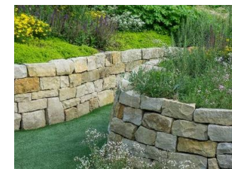
Illustration d'enrochements à blocs et joints alternés de petits moellons de pierre
