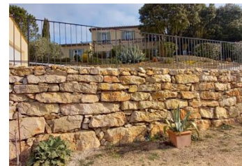
Illustration d'enrochements à blocs et joints alternés de petits moellons de pierre
