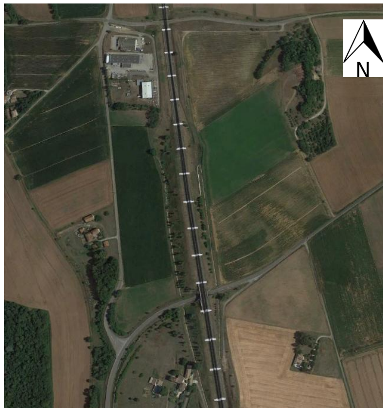
Vue aérienne sur le site
