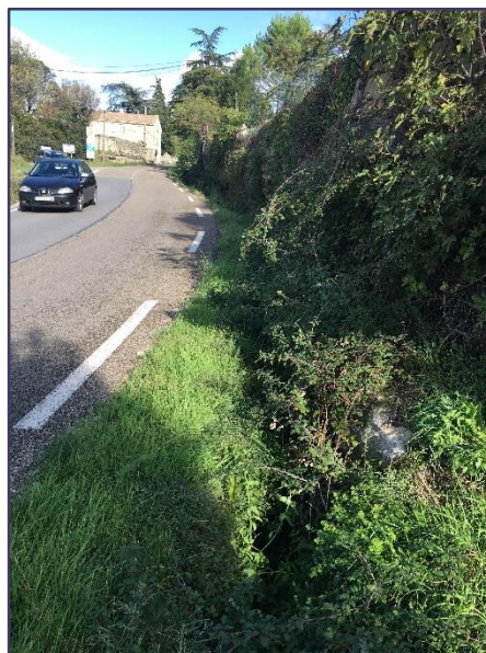
Figure 29. Accotement RD982 route d'Arpaillargues
