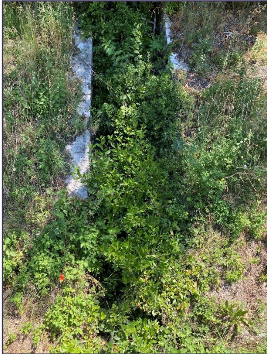
Figure 31. Entrée de l'ouvrage - Chemin de l'Ancienne Gare
