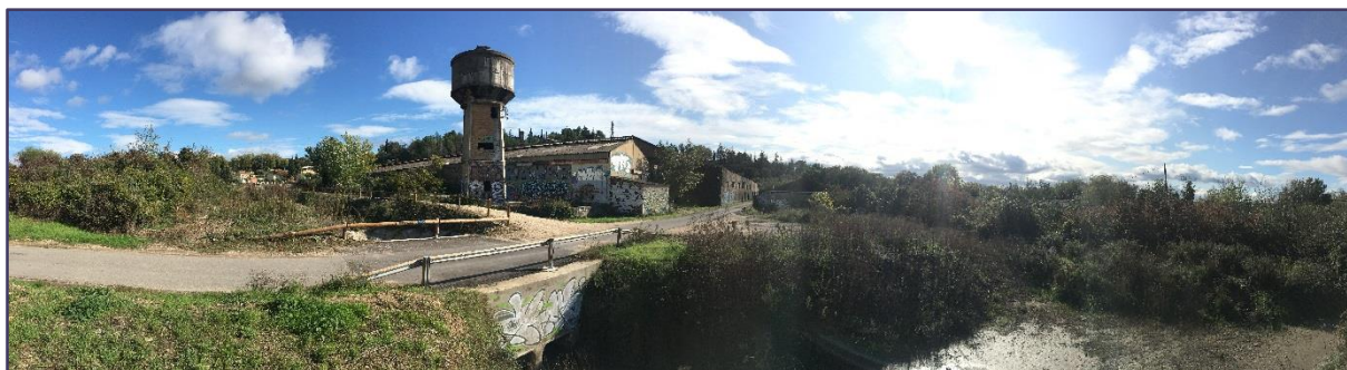
Figure 21. Ouvrage cadre existant - Chemin de la Gare (zone nord)
