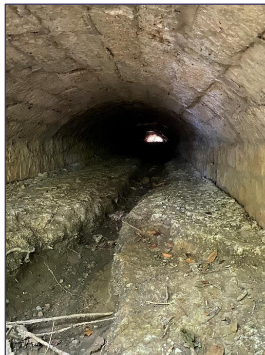
Figure 36. Ouvrage hydraulique n°16
