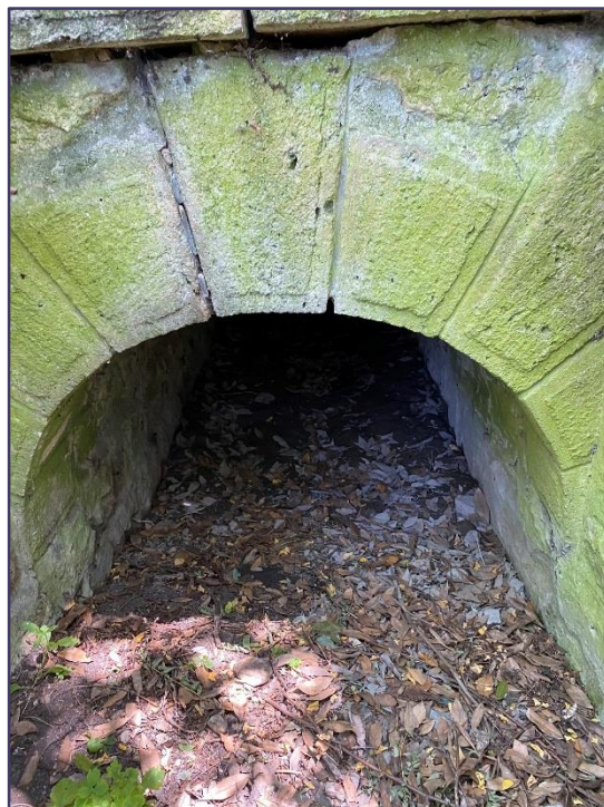
Figure 33. Aval ouvrage hydraulique n°15
