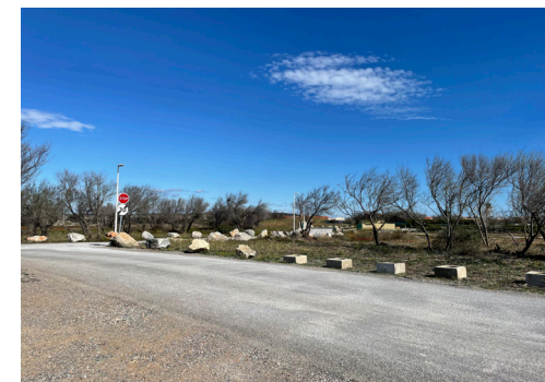
2- Voirie traversant le site avec accotements en pierre
