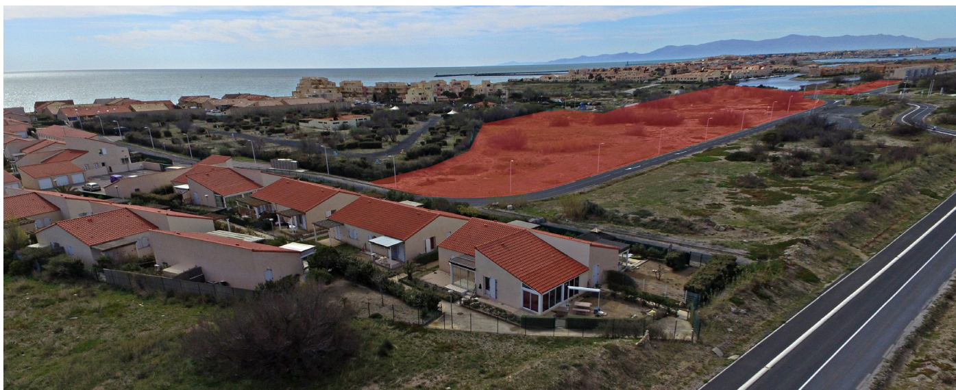
Le projet au sein du tissu urbain existant - Vue depuis la rue Albert Lecoq, au niveau de la résidence Les Mas de la Plage - GAU
