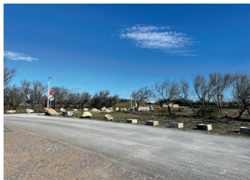
Voirie traversant le site avec accotements en pierre
