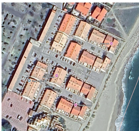
Typologie de bâti existante à côté du site de projet, sans aucun espace végétal et totalement imperméabilisé et goudronné
