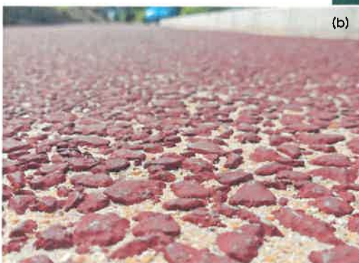
-Photos 4- (a) Voie rouge après sa mise en œuvre en octobre 2023. (b) Détail de la voie dix mois après sa mise en œuvre.
