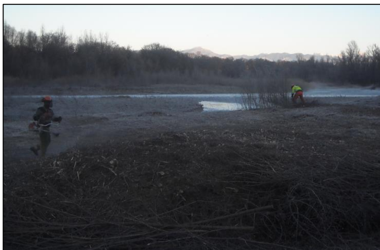
Figure 2 : Traitement de la strate arbustive en cours (opérateurs avec matériel de bucheronnage)
