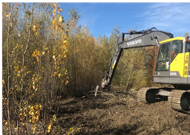
Figure 5 : Pelle munie d'un godet en train d'essarter de la végétation ligneuse dense
