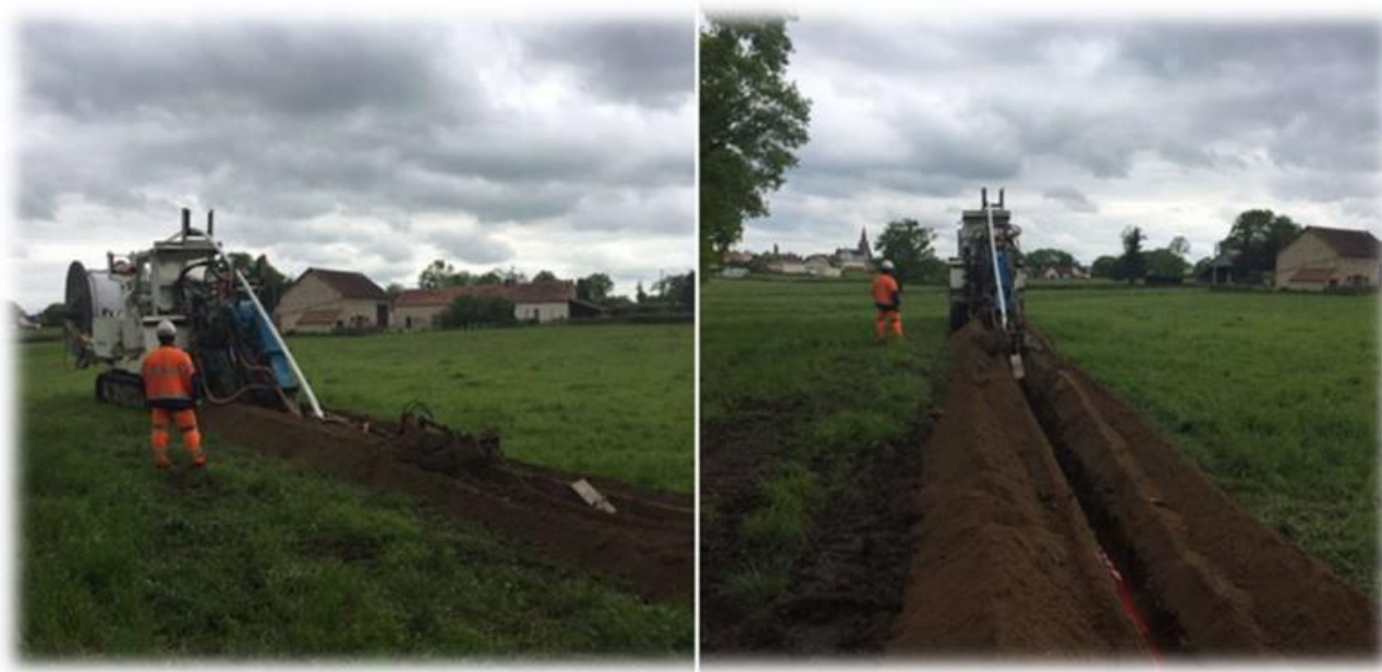
Figure 2 : Exemple de chantier d'enfouissement d'un réseau électrique en terres agricoles (source : Cegelec infra)
