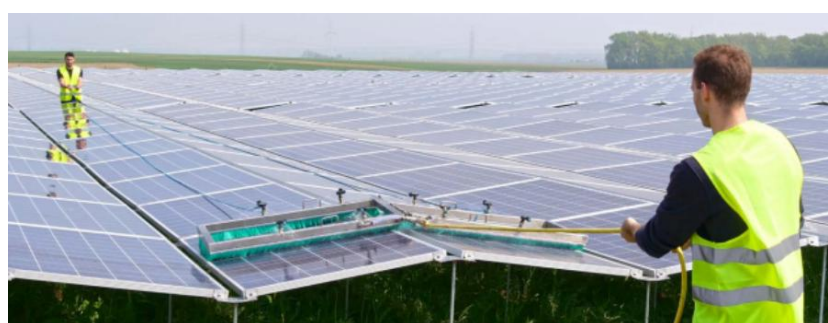
Figure 1 : Illustration de nettoyage de panneaux
