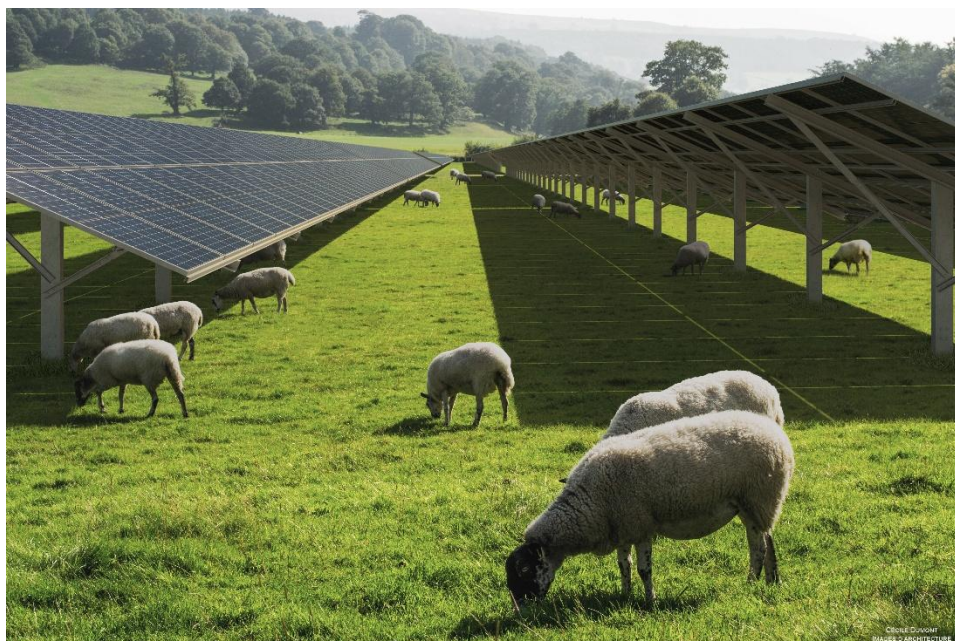
Exemple de centrale agrivoltaïque ovine avec panneaux sur structures fixes mono-pieux surélevées à 1m50 de point bas (source : JPee)
