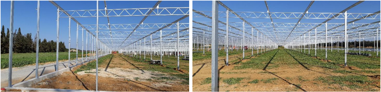
Figure 10 - Montage structure d'une serre photovoltaïque. Reden.
