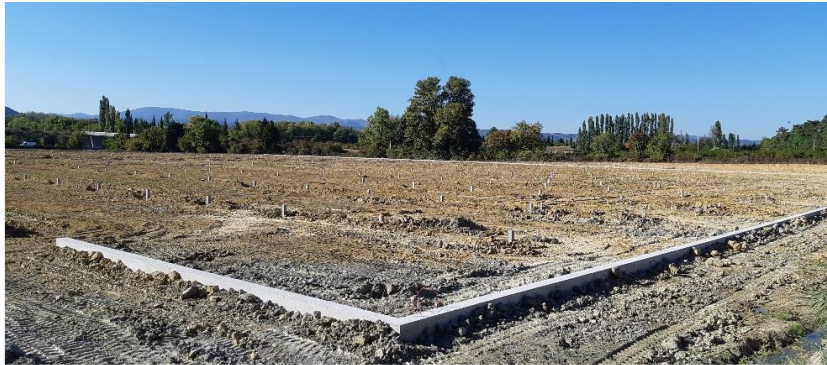
Figure 12 - Fondations béton extérieures (longrine). Reden.
