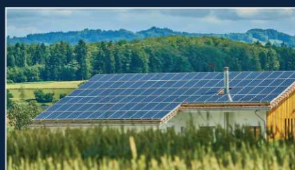
Les bâtiments agricoles équipés d'une toiture solaire
