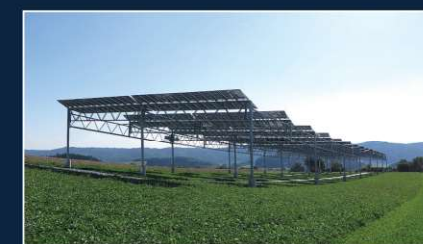
Les ombrières agrivoltaiques fixes
