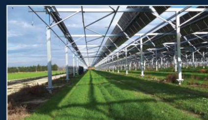
Les ombrières agrivoltaiques dynamiques / mobiles
