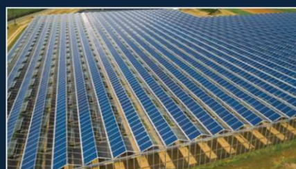
Les serres photovoltaïques
