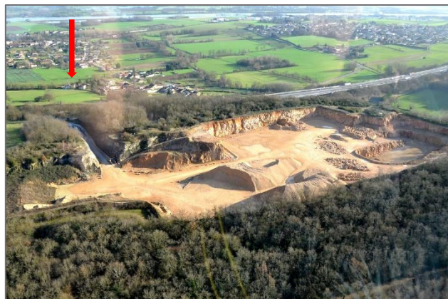
Vue sur l'entrée du site – Parcelle ZA 1
