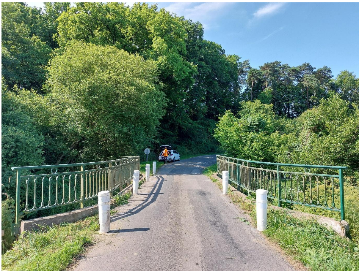
Photographie 4 : Vue depuis le nord
