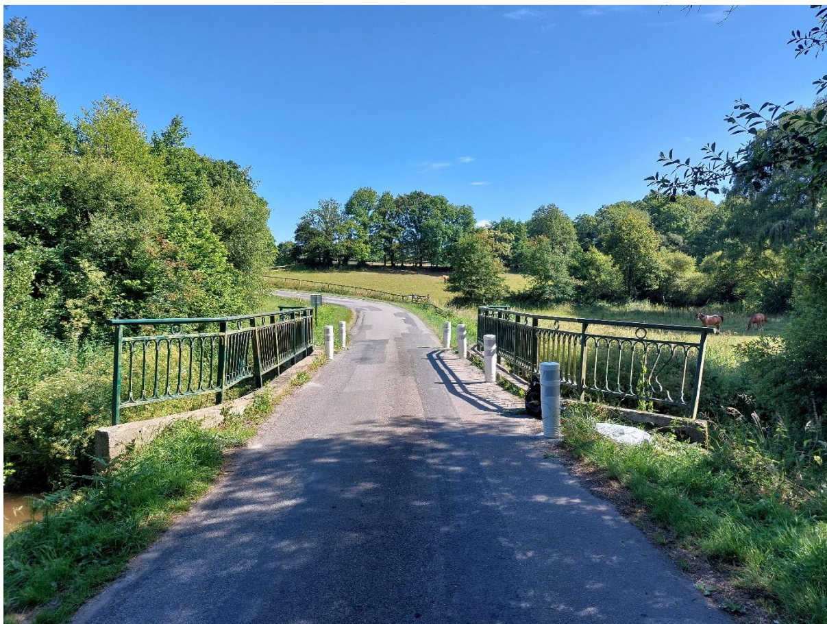
Photographie 3 : Vue depuis le sud
