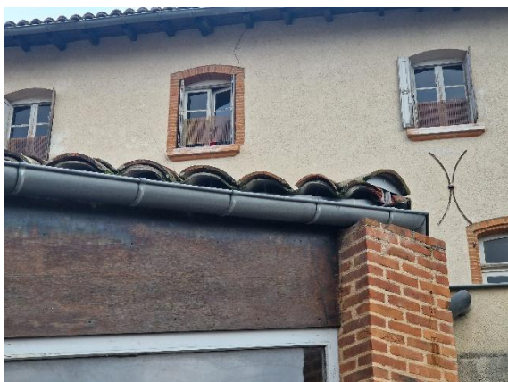
Toiture du bâtiment 2
