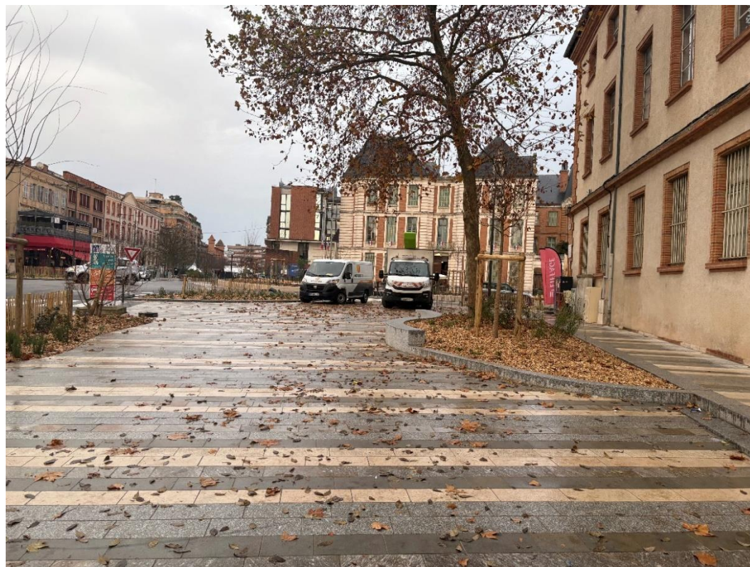
Photo prise depuis les Allées de Mortarieu
