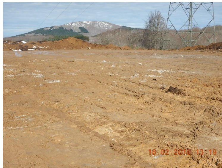
Illustrations 8 et 9 : Terrassement de la parcelle et gravillonnage de la plateforme HTB
