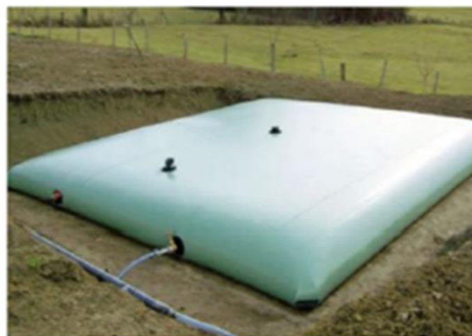
Illustration 15 : Réserve incendie 120 m 3
