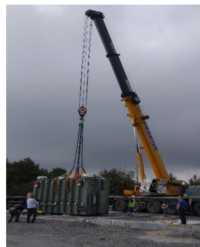
Illustration 14 : Pose du transformateur de puissance
