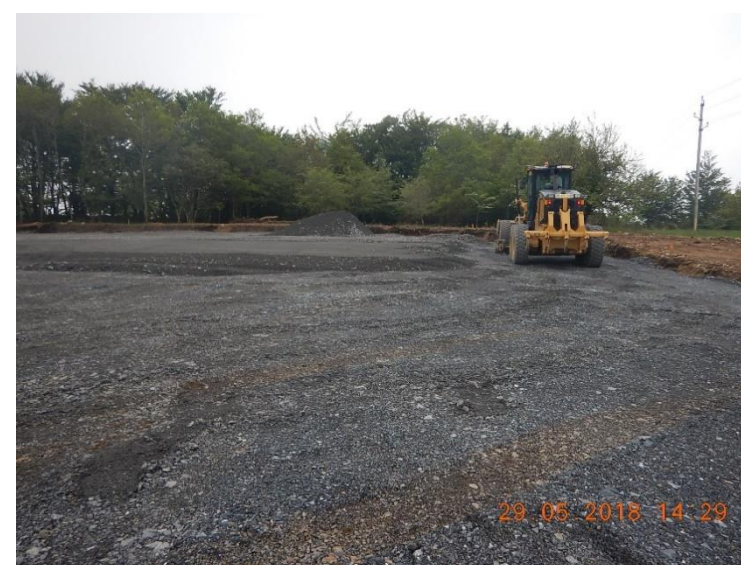
Illustrations 8 et 9 : Terrassement de la parcelle et gravillonnage de la plateforme HTB
