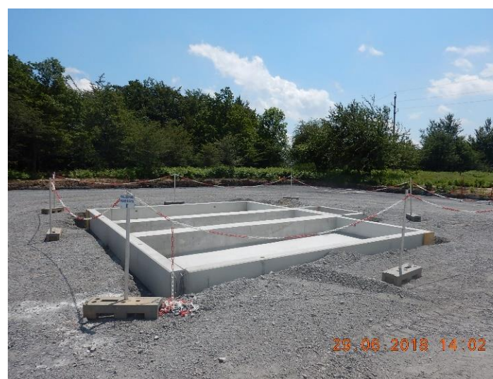
Illustration 12 : Création des fondations des transformateurs
