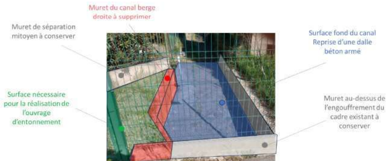
FIGURE 1 : MODIFICATIONS PROJETE DE L'OUVRAGE D'ENGOUFREMENT ACTUEL
