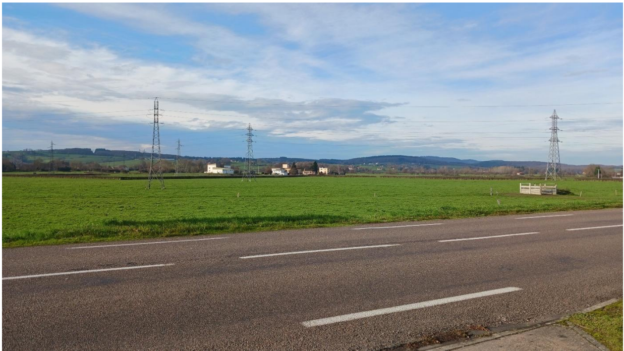
Figure 11 : Paysage rural et agricole dans lequel est implanté le poste source de Gueugnon, NEGE, décembre 2025
