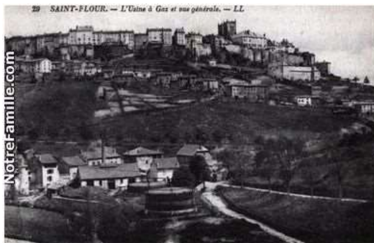
Figure 2 : photographie d'archives de l'ancienne usine à gaz.
