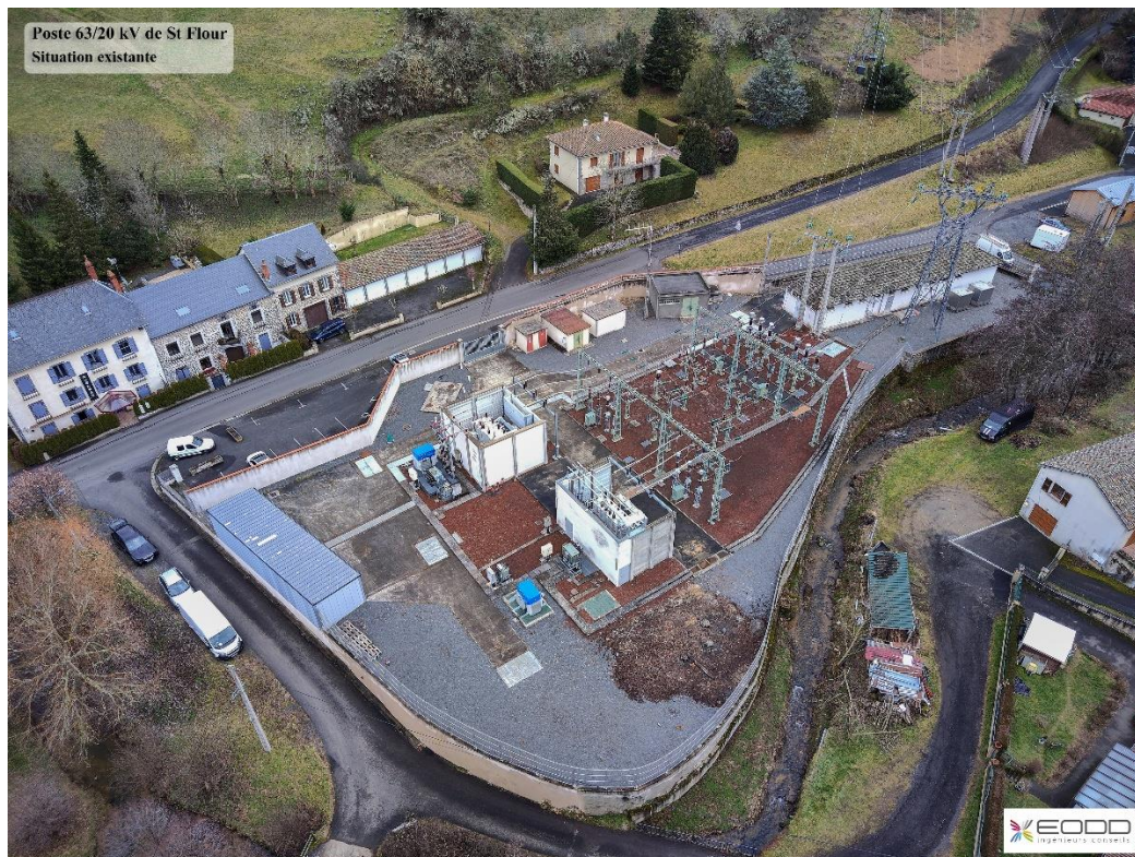
Illustration 7 : Vue aérienne du poste existant
